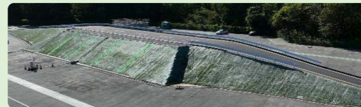
※中間貯蔵施設での除去土壌を利用した道路盛土実証
